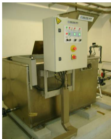
Figura 40 - Sistema de doseamento de polímero.
