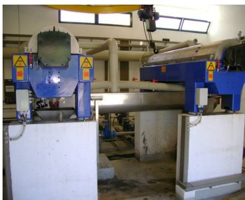
Figura 39 - Centrifugas.
