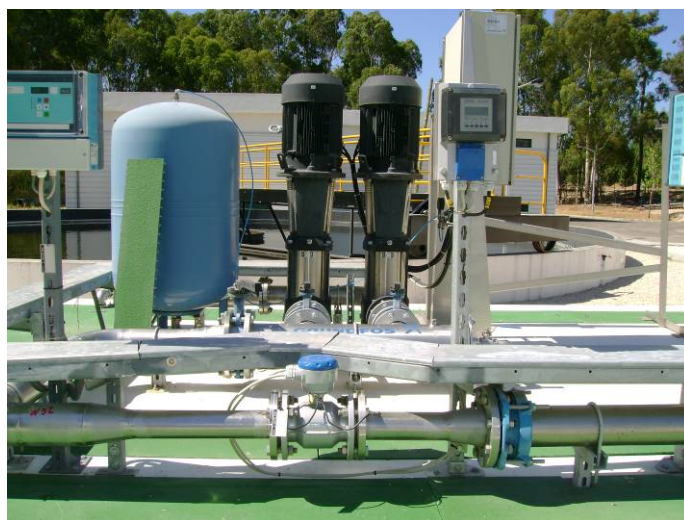
Figura 34 - Grupo hidropressor.
