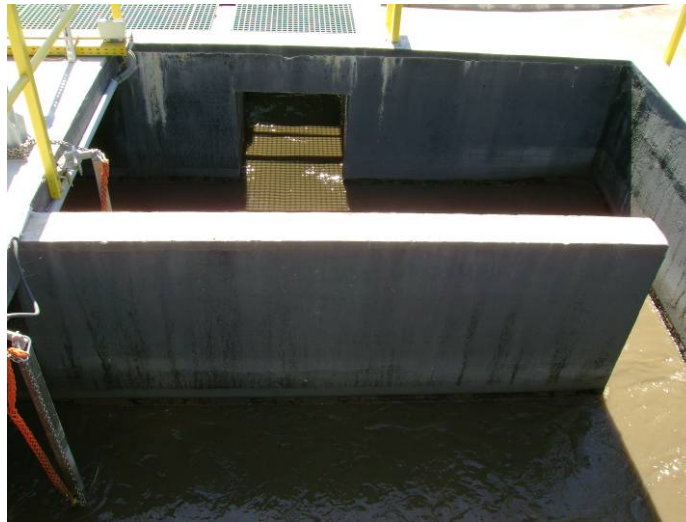
Figura 25 - Tanque de Contacto “selector”.
