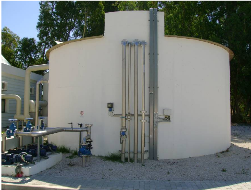
Figura 35 - Espessador gravítico.
