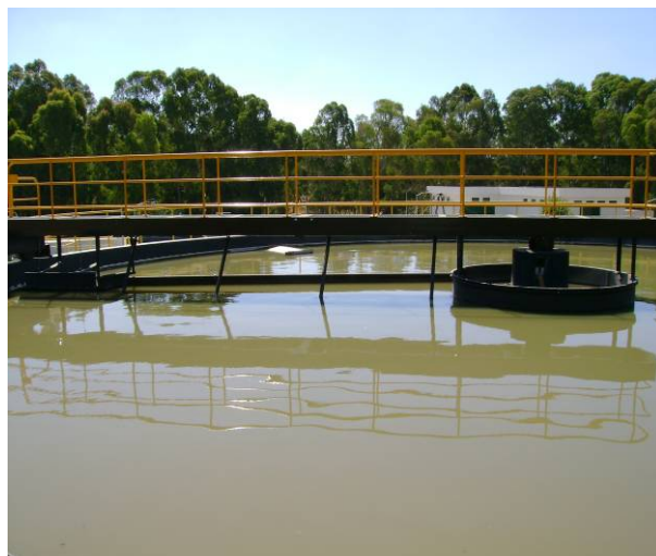
Figura 24 - Ponte Raspadora do Dec. Primário
