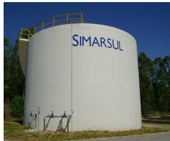
Figura 38 - Digestor anaeróbio reabilitado.
