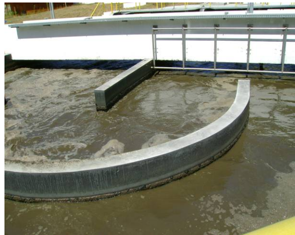
Figura 28 - Zona anóxica do reactor biológico.
