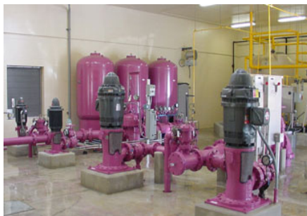
Figura 2 - Sinal indicativo. Figura 3 - Bombas de reutilização das AR. Figura 4 - Acessórios.
