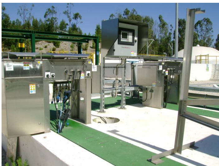
Figura 32 - Sistema de controlo da desinfecção UV Figura 33 - Lâmpadas UV presentes no canal.
