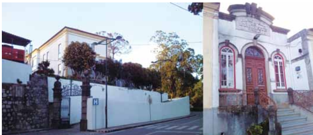
Figura 9 Hospital da Misericórdia com destaque para a entrada principal do edifício. Visível a placa lítica com os dizeres Hospital de Monchique-1921. Atente-se no equilíbrio da arquitectura, bem enquadrado para a época
