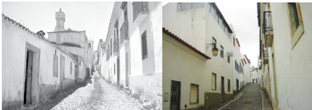
Figura 8 Na foto de cima a Calçada de Santo António onde se pode ver o corpo do antigo hospital, com a chaminé de saia, e ao fundo a torre da igreja. A foto de baixo, actual, tirada sensivelmente da mesma posição
