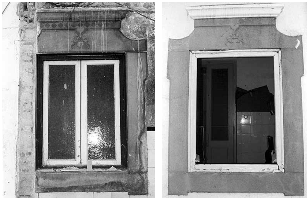
Figura 8 Imagens de algumas das janelas localizadas nas traseiras do antigo Sanatório
