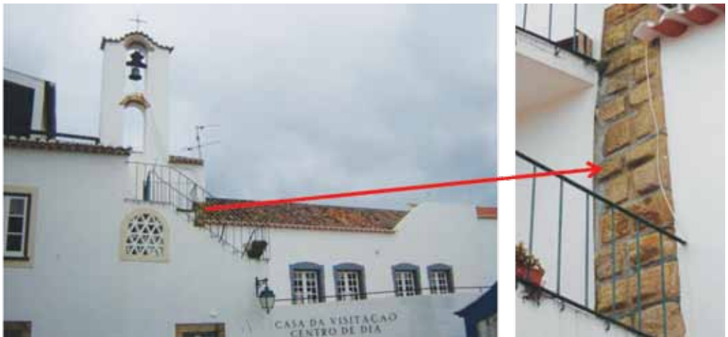
Figura 3 Enquadramento actual do edifício onde funciona o Centro de Dia, na Rua de Santo António. Pormenor dos cunhais almofadados que delimitam a cabeceira da igreja com o que resultou da intervenção no antigo hospital
