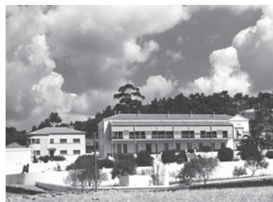
Figura 10 Sanatório Carlos Vasconcelos Porto
