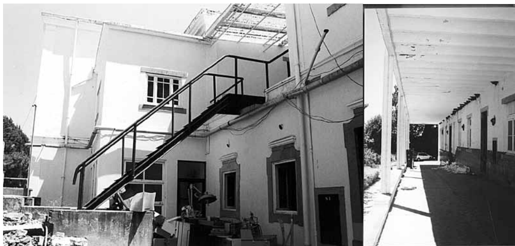
Figura 9 Imagens das escadas e da varanda construídas com traves dos caminhos-de-ferro
