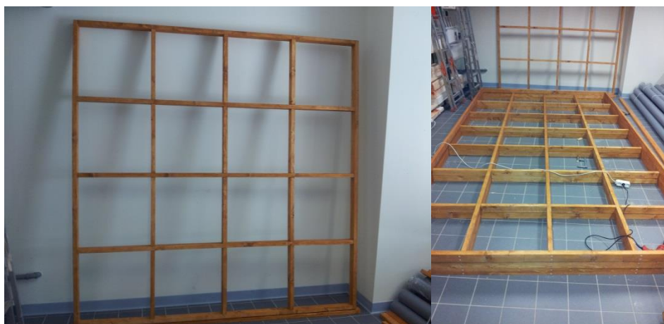
Figura 2 - Fase de construção da estrutura da câmara.
