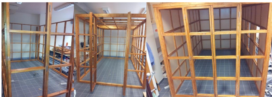
Figura 3 - Fase final de construção da estrutura da câmara.
