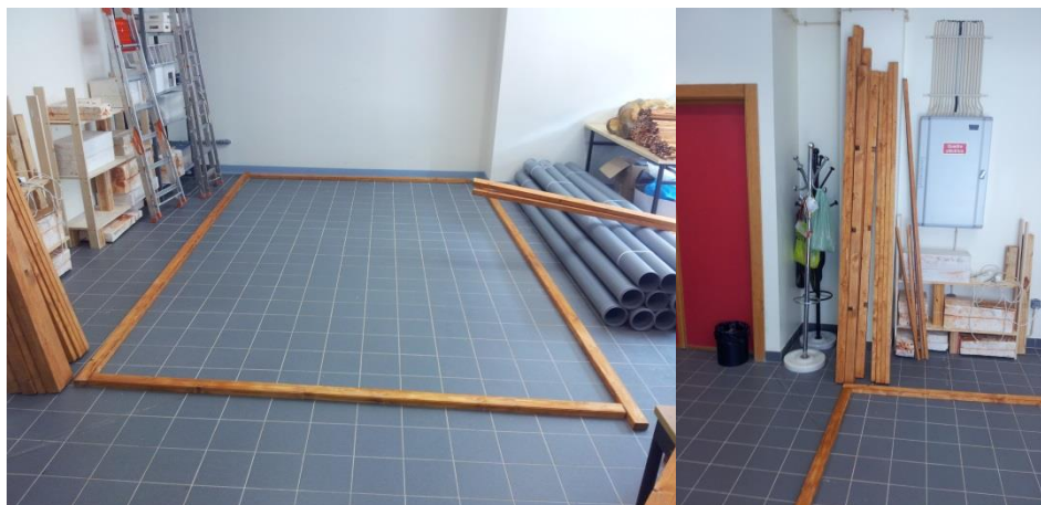
Figura 1 - Fase inicial da construção.
