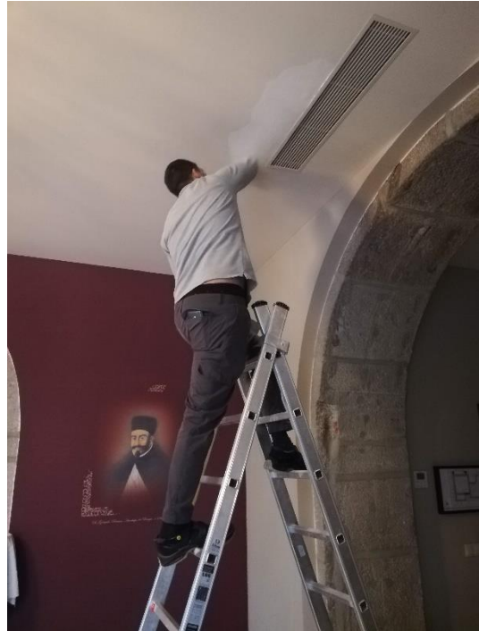
Figura 82 - Trabalho de Manutenção de um teto com humidade
