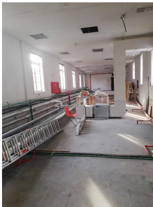
Figura 59 - Área Técnica do Sótão do edifício Diogo de Sousa
