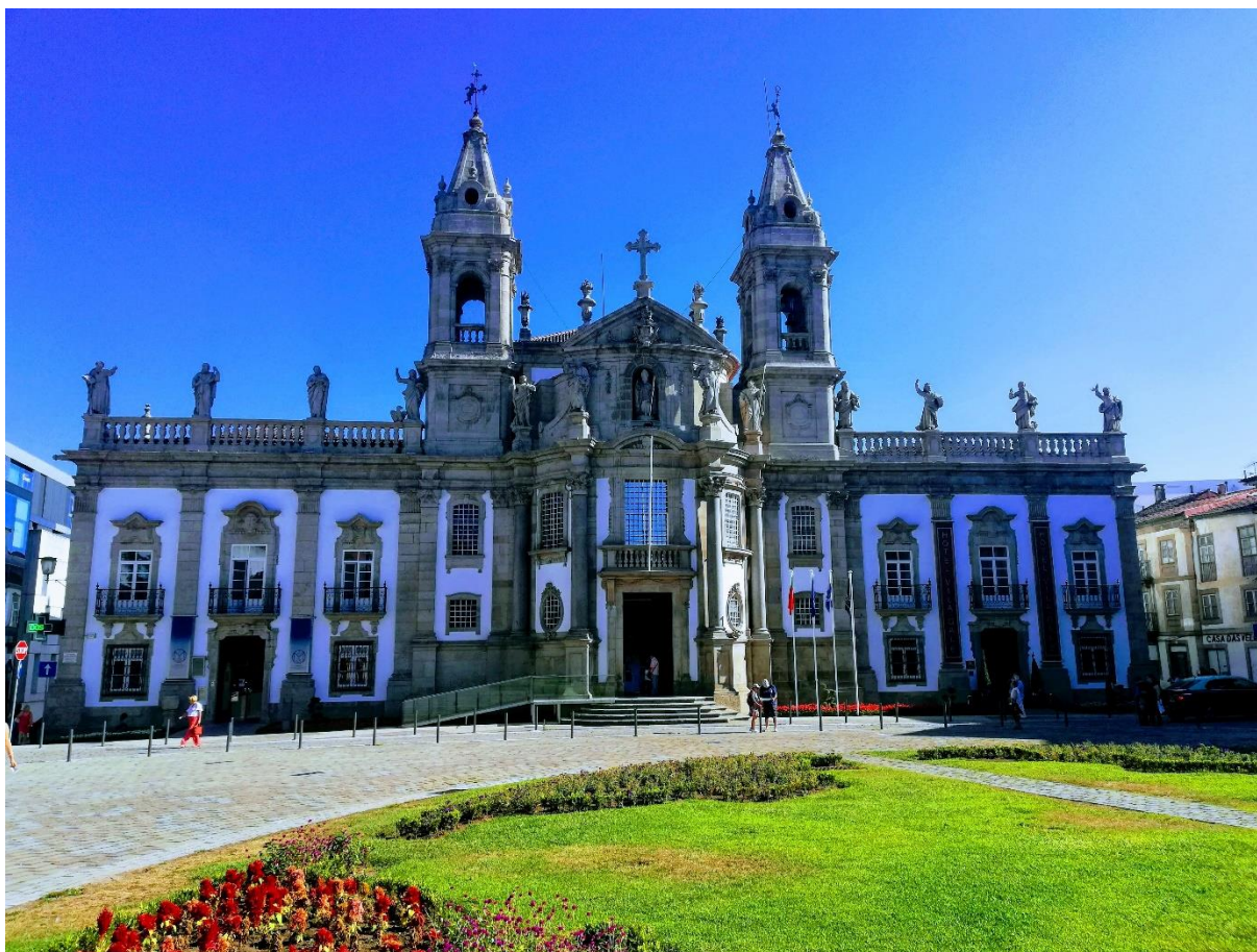
Figura 3 - Fachada do Antigo Hospital de São Marcos e a sua Igreja ao centro (hoje Hotel Vila Galé Collection Braga)
