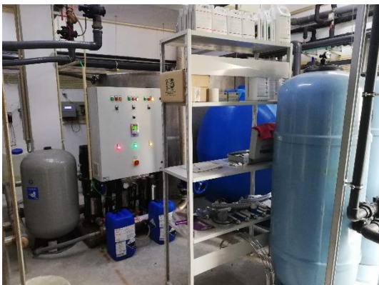
Figura 67 - Quadros elétricos das Piscinas
