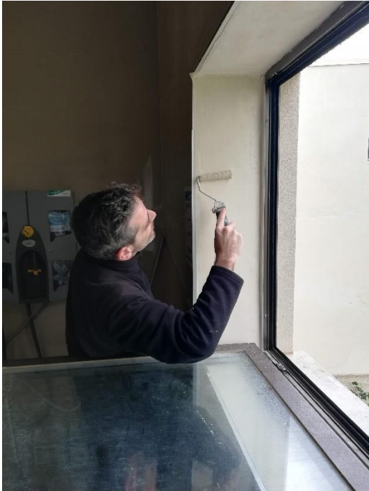
Figura 79 - Trabalho de Manutenção de pintura
