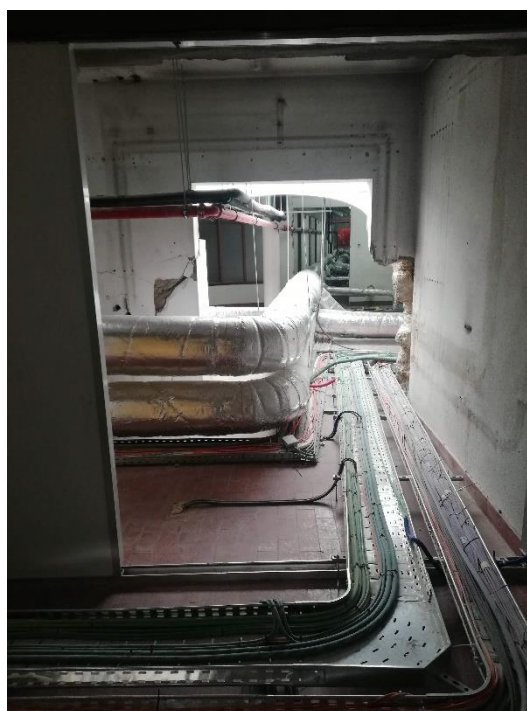
Figura 60 - Área Técnica do sótão do edifício Caetano Brandão
