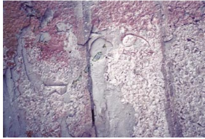
Marcas de Canteiro da Ponte do Barão
