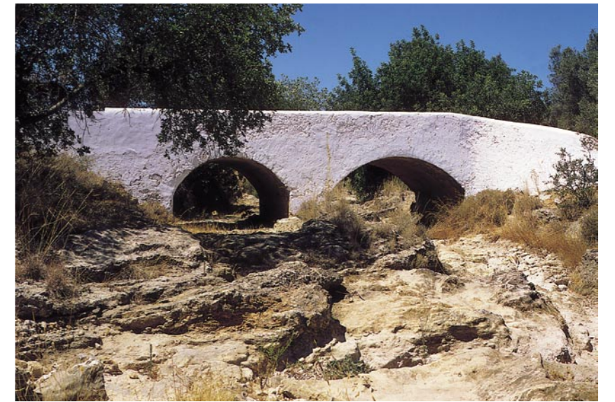
Ponte dos Calieços
