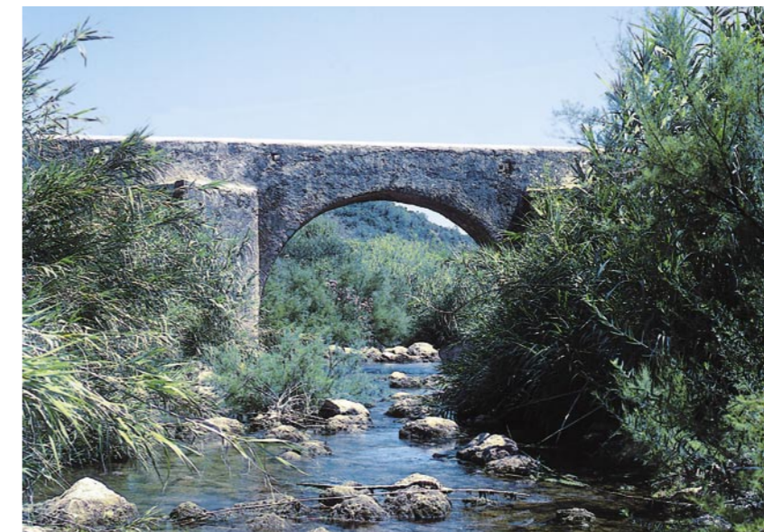
Ponte de Paderne
