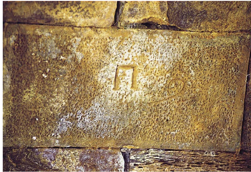
Marcas de Canteiro da Ponte de Silves
