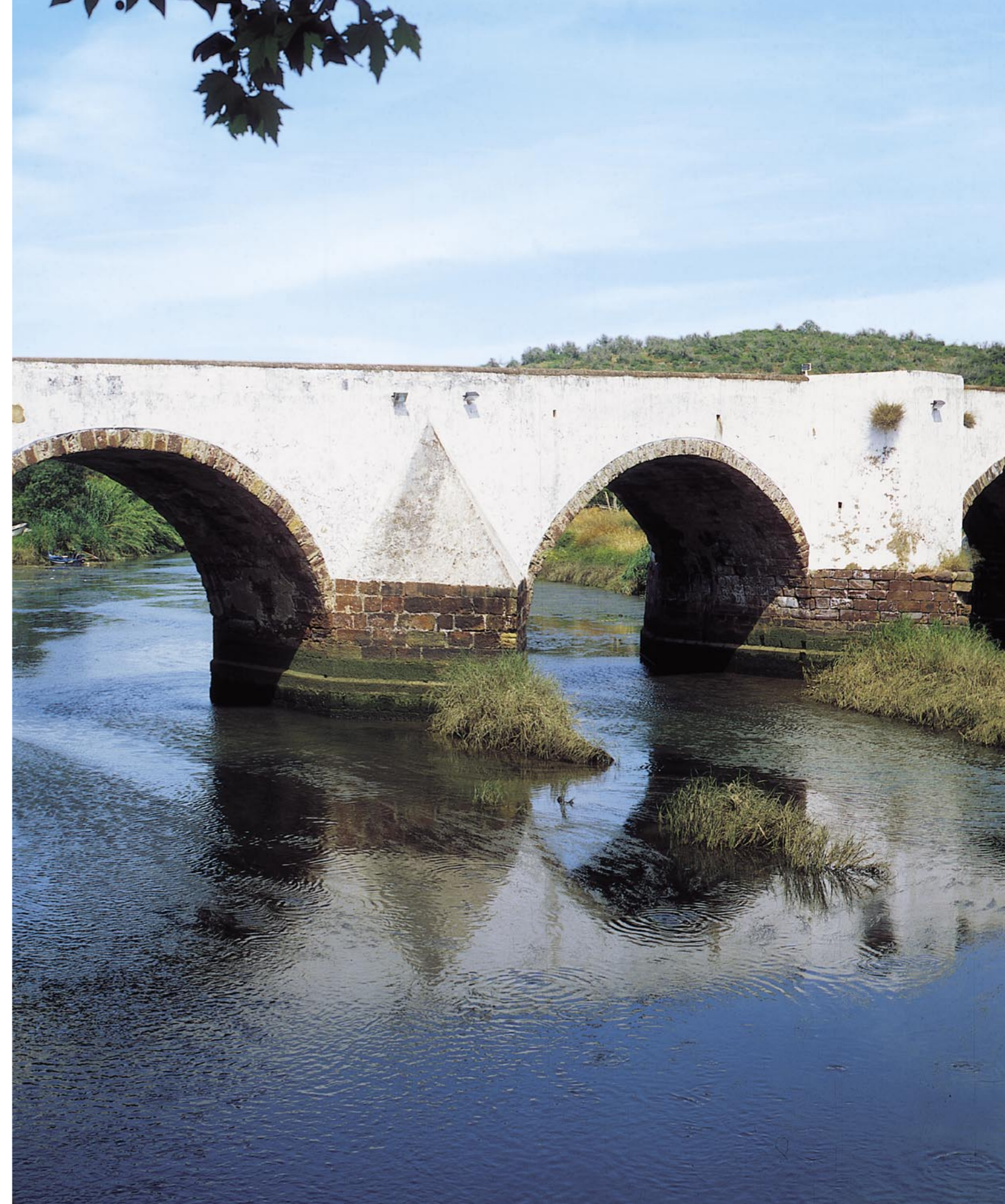
Ponte de Silves
