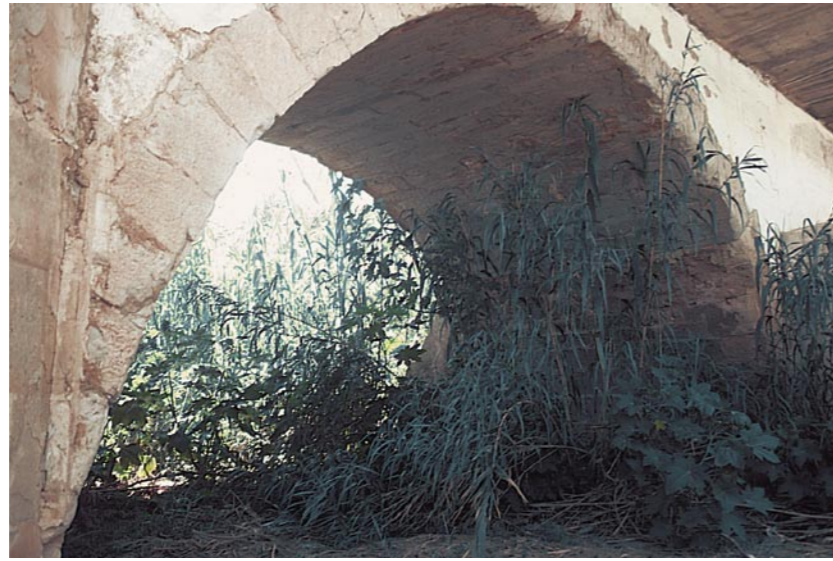
Ponte do Barão
