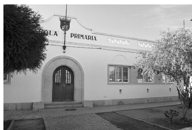
Figura 7 Olhão, escola primária do tipo Algarve (1 piso, 2 salas) definido Alberto Braga de Sousa em 1948. Vítor Ribeiro, 2016.
