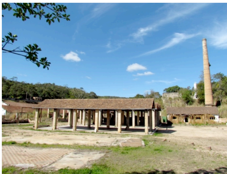
Figura 2 - Estado atual das antigas instalações da Cerâmica Nacional, 2018. Fonte: Fotografia produzida pelo autor.
