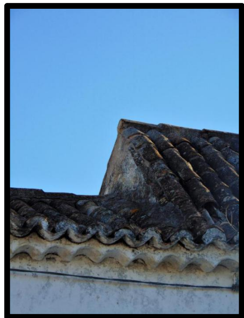
Os telhados da nave e capela-mor de São Pedro ▶
