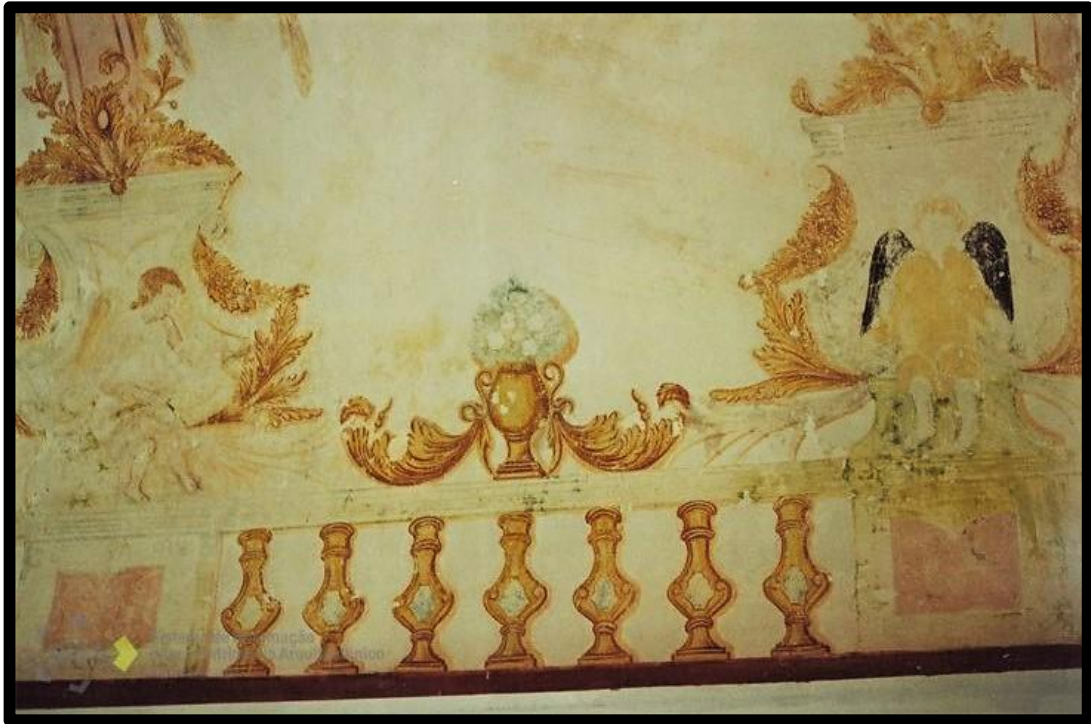
▲ Detalhe da balastrada fingida no teto da nave do Calvário 437
