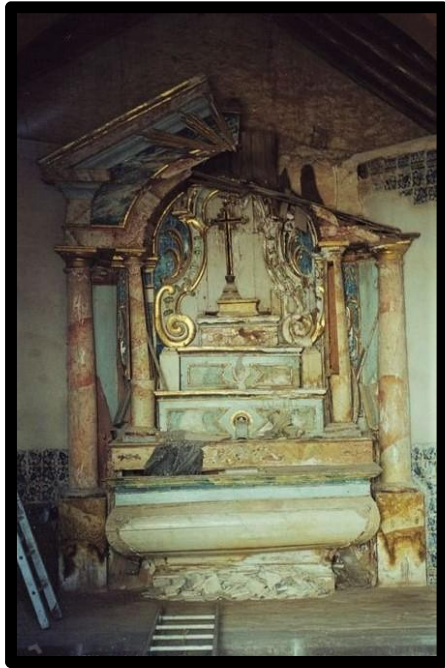
◀ O altar de São Pedro (já danificado) antes de cair 539
