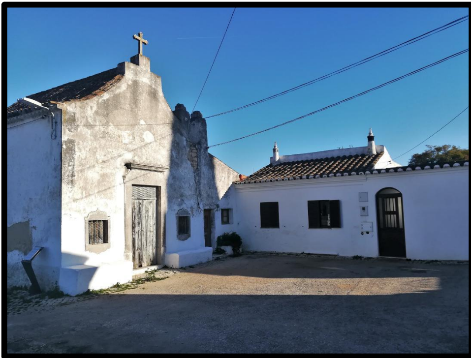
▲ São Pedro, a casa do ermitão e uma habitação adjacente (em 2020)
