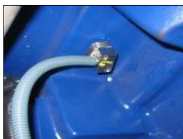
Figura 20. Instalação do sensor com base roscada (Teng et al., 2021)
