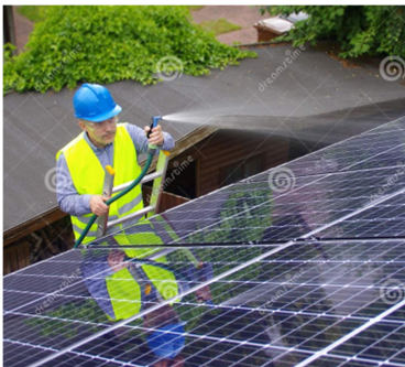
Figura 25 – Limpeza de módulos com água [25].
