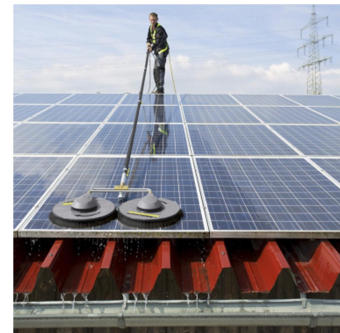
Figura 27 – Limpeza manual de módulos fotovoltaicos [28].
