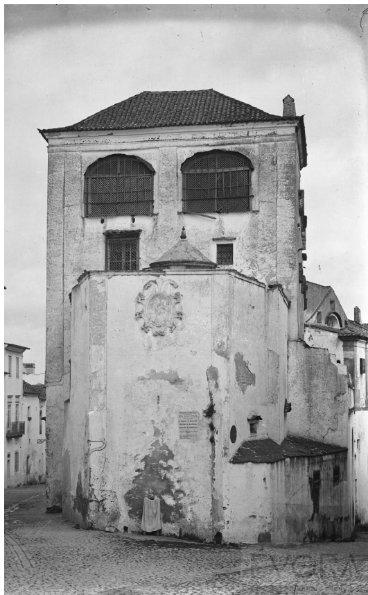
Figura 2 - Vista poente do Convento de Nossa Senhora do Paraíso evidenciando a cabeceira da igreja do convento e a torre-mirante (antes da demolição). Fonte: José António Barbosa (1900) - Arquivo Fotográfico da Câmara Municipal de Évora [AFCME], CME0287.
