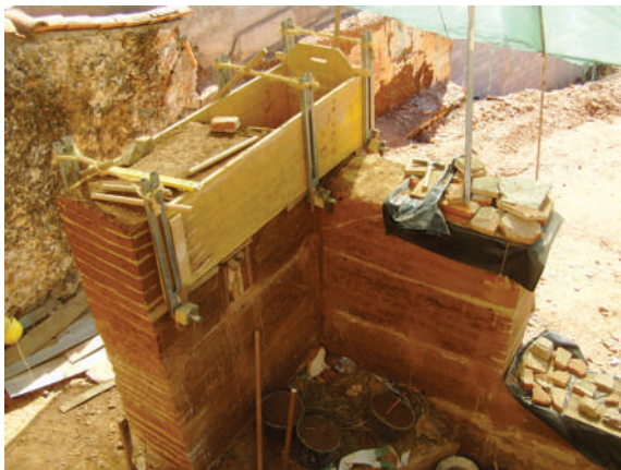
Fig. 1 Parede em taipa
