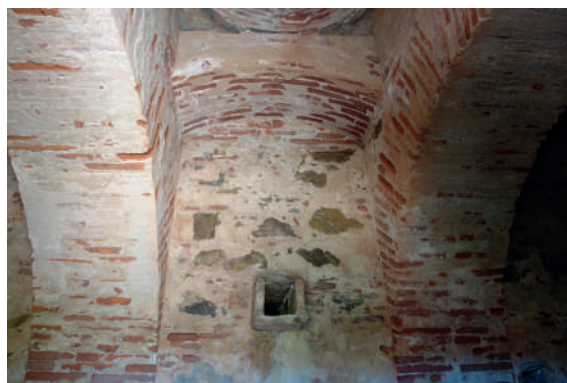
Fig. 7 Cisterna em casa no arrabalde da Vila
