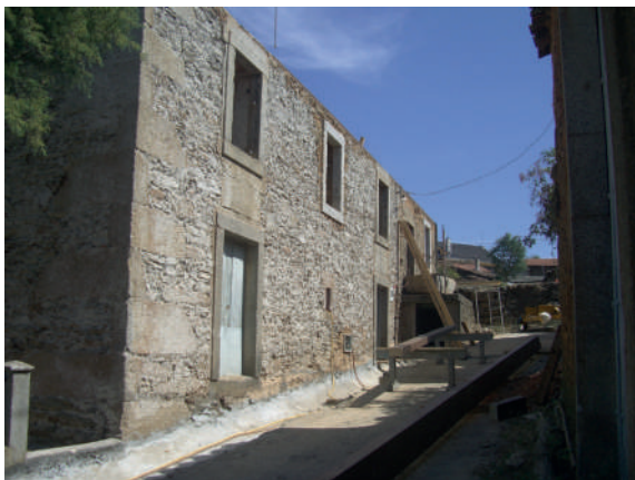
Fig. 3 Casa em Angueira, concelho de Bragança, durante as obras de reabilitação
