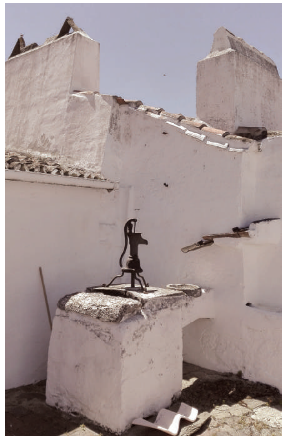
Fig. 7 Entrada de cisterna sob açoteira
