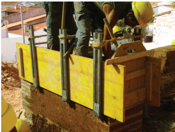
Fig. 2 O estojo: taipais (painéis laterais), frontal, e peças de fixação (agulhas, costaneiros, côvados). O estojo utilizado na obra do Sobral da Adiça apresenta algumas inovações relativamente ao tradicional, tais como os costaneiros em tubo metálico, ou o uso de painéis pré-fabricados em madeira
