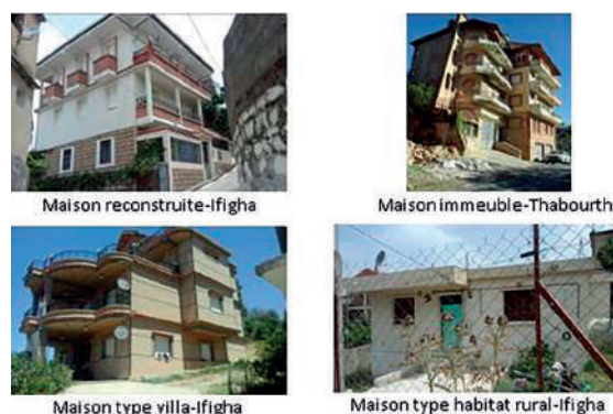
Fig. 4 Relevé des nouveaux types de maisons. Maison reconstruite à Ifigha, maison immeuble à Thabourth, maison type villa à Ifigha, maison type habitat rural à Ifigha (Zoulikha Ait-Lhadj, enquête terrain 2017/2018)
