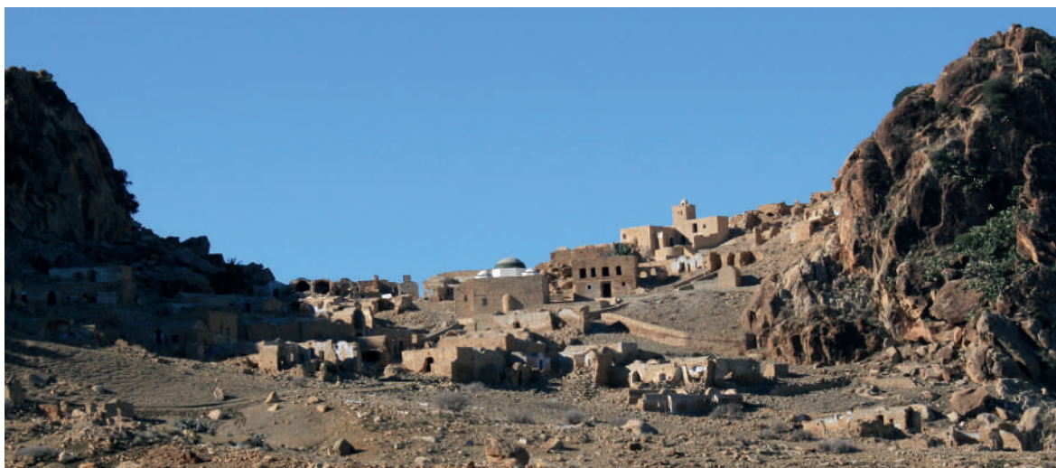
Fig. 2 Vue générale du village de Zriba
