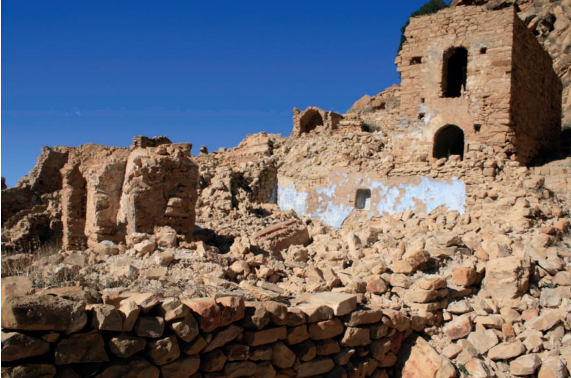
Fig. 8 Maison à Zriba
