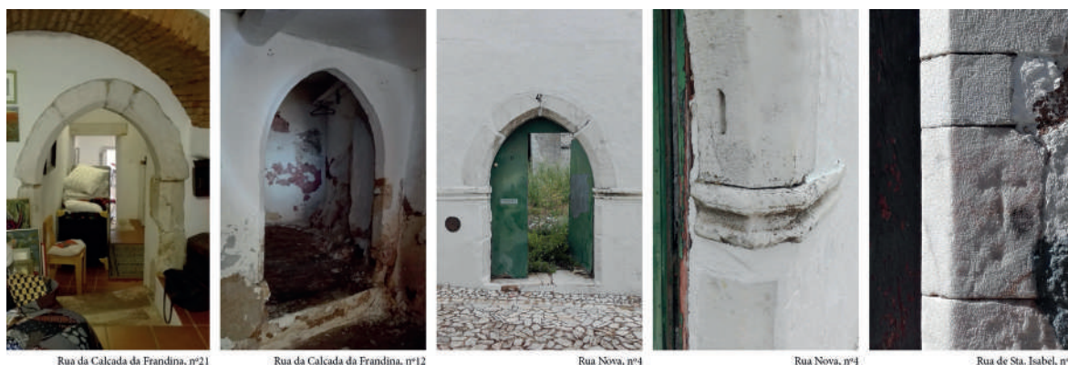
Fig. 4 Arcos ogivais em mármore e tijolo. Marcas em cantarias exteriores
