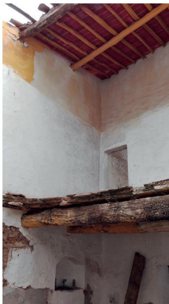
Fig. 5 Estruturas de piso e cobertura em madeira e ladrilho
