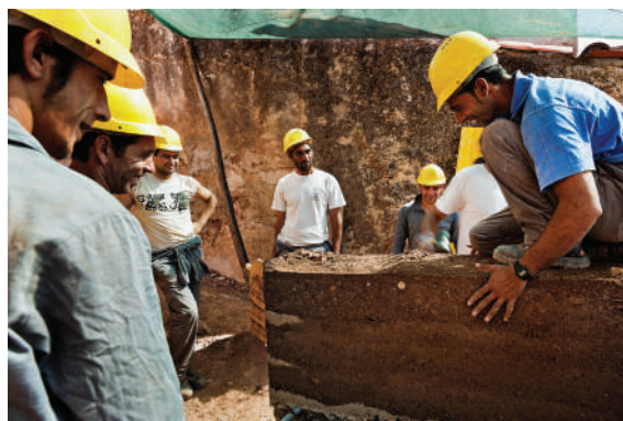
Fig. 5 Parede em taipa, logo após descobrimento. (Rui Vasco)
