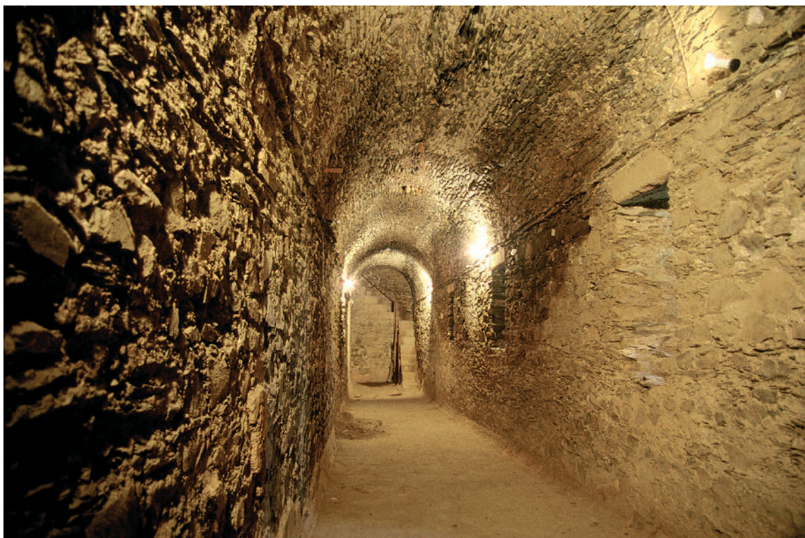
Fig. 4 Vista interior do criptopórtico (Arquivo CAM)
