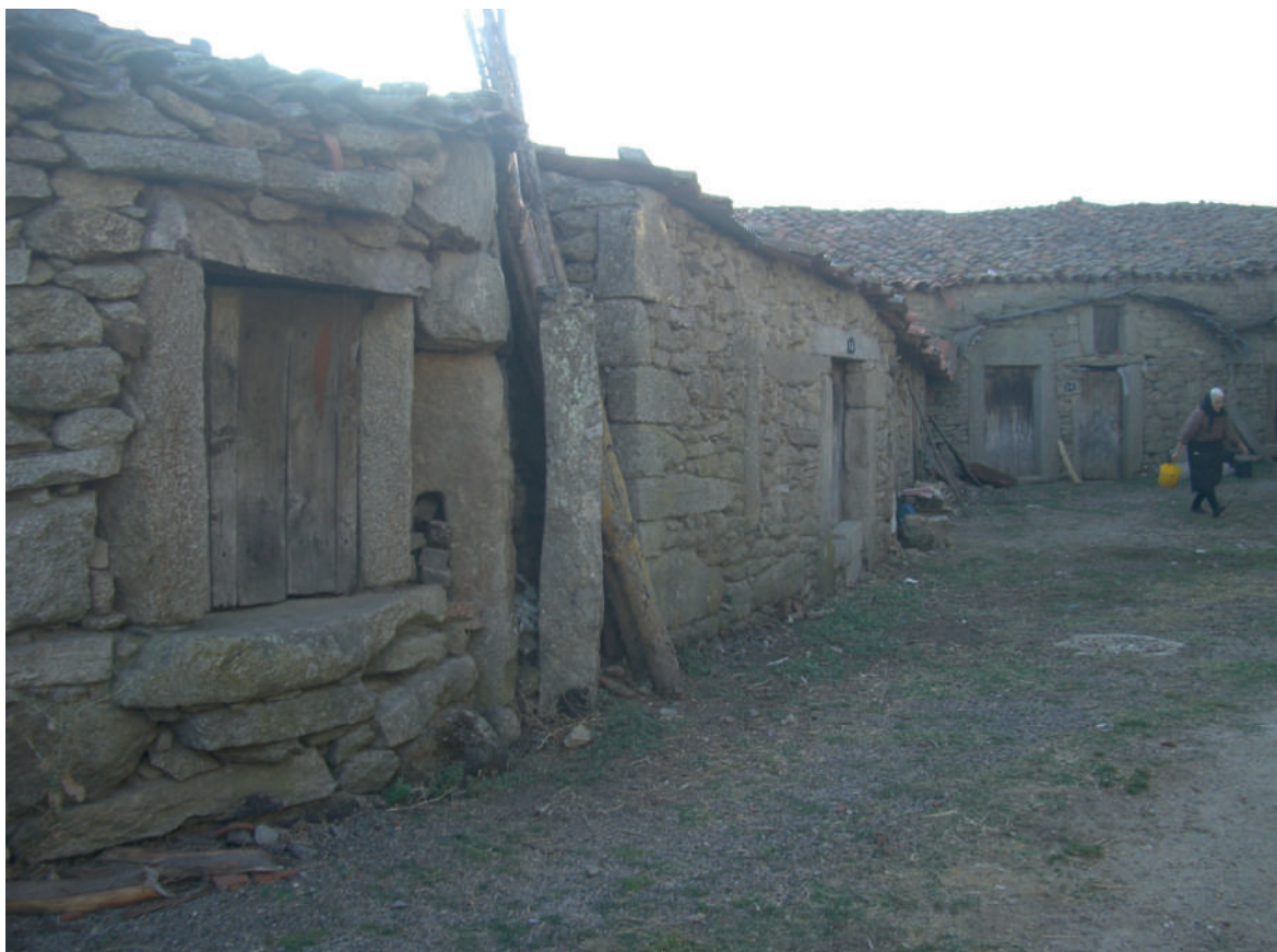
Fig. 5 Fonte da Aldeia, concelho de Bragança. Casas em alvenaria de granito com paredes interiores em adobe
