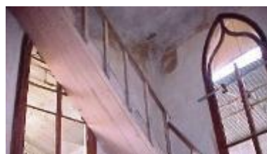
Figura 10 - Interior da Torre.
