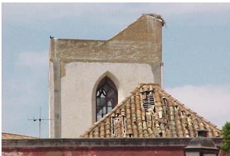
Figura 17 - Telhado da caixa de escadas.
