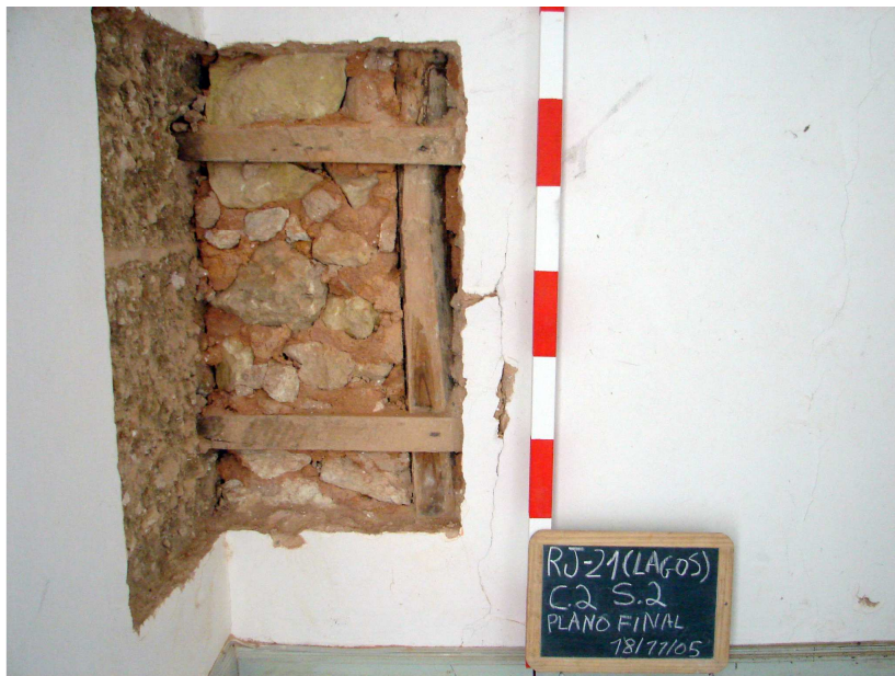
Figura 9 – Rua do Jardim, nº 21, Lagos. Sondagens diagnóstico efectuadas no interior dos edifícios. Compartimento 2 (Fonte: Autora).
