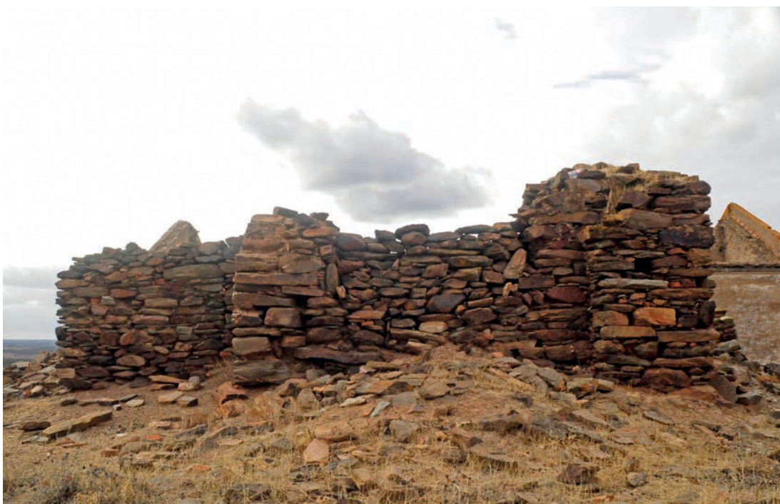
Figura 5 – Vista exterior del ábside (Fase 1) con los volúmenes añadidos durante los siglos XVII y XVIII en su costado sur (fase 3 y 4).
