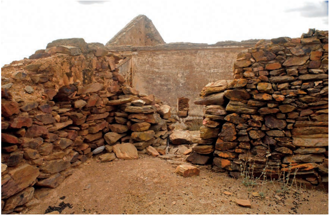
Figura 6 – Vista interior del aula y muro de reparcelación de época contemporánea (Fase 4).
