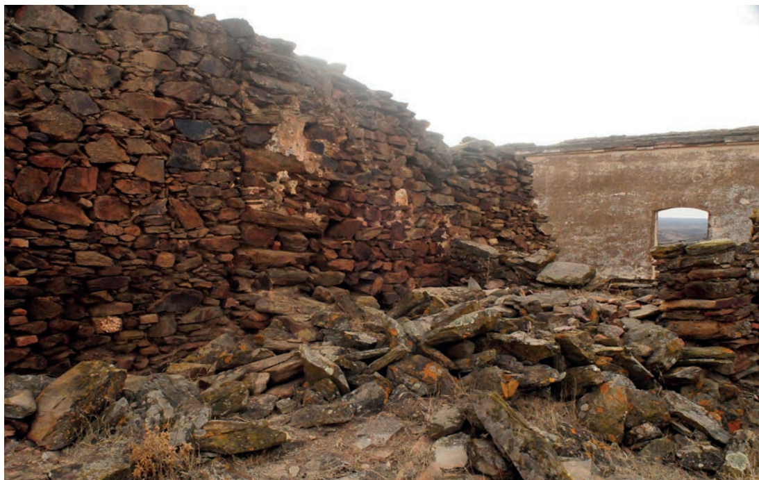
Figura 4 – Fases 1 y 2. Vista exterior del muro norte, donde se puede apreciar el adosamiento simple de las fases.
