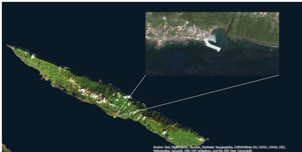
Figura A 6.2. Localização da estrutura marítima da Calheta (São Jorge).
