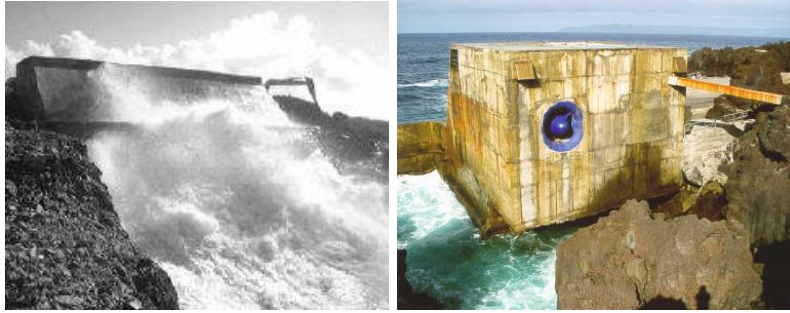
Figura 2.3. Sistema coluna de água oscilante: Central LIMPET (esquerda) e Central do Pico (direita). Adaptado de (Martins, 2009 e Falcão, 2007).
