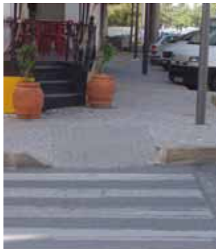
Quarteira – Rebaixamento de lancil inadequado
