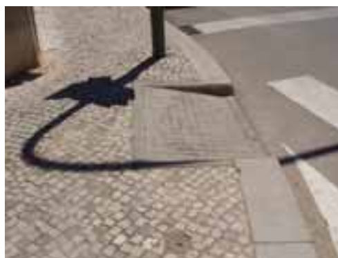
Rua N. Sra de Fátima (Loulé) – Rebaixamento de lancil com 15% de inclinação, inacessível às pessoas em cadeiras de rodas
