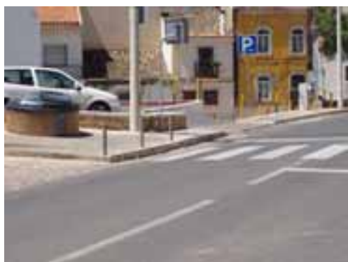
Rua N. Sra de Fátima (Loulé) – Passeios estreitos e ausência de rebaixamento de lancil na passadeira
