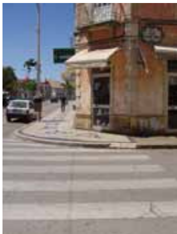
Entroncamento da Av. Costa Mealha com a Rua Padre A. Vieira (Loulé) – Rebaixamento de lancil inadequado
