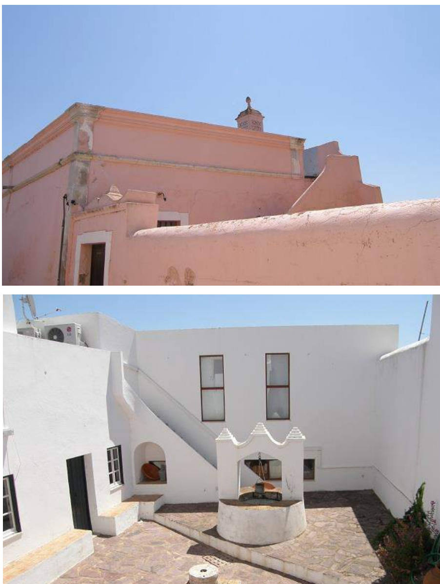
Figura 3.14 – Exemplos de açoteias na “Casa Baluarte” e na “Casa dos Condes” em Alcoutim, 2018; fotos da autora.
