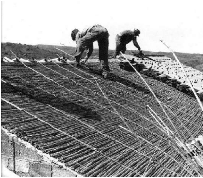
Figura 3.1 – Telhado em Alcoutim, Corte Serrano.
