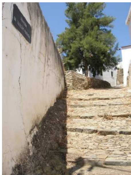
Figura 3.18 – Exemplo de parede sobre afloramento rochoso, Alcoutim, 2018; foto da autora.
