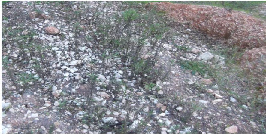
Figura 5.7-Asfalto e solos escavados.
