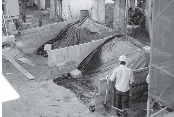
Figura. iii-Armazenamento de materiais agregados nos estaleiros de obras.
