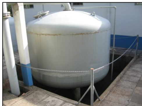
Figura 12- Filtro rápidos na ETA de Castro Verde
