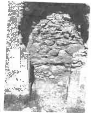
Figura 16 - Porta de acesso ao anexo em 2007. Observa-se o negativo da moldura em fingido de pedra (M. Ramalho)
