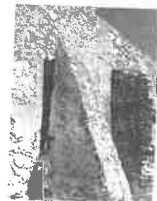
Figura 20 - Registo da existência de dois rebocos no exterior da Ermida (M. Ramalho, 2007)
