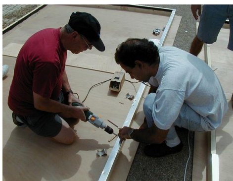
Figura 54 - Construção de um colector solar.
