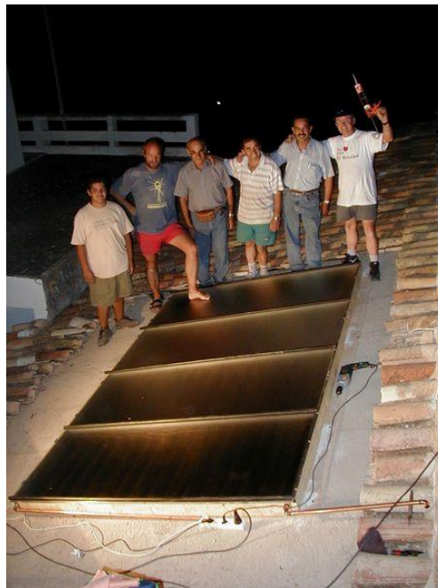
Figura 55 - Instalação de um colector solar.
