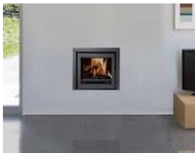
Figura 5 - Recuperador de calor instalado de raiz.
