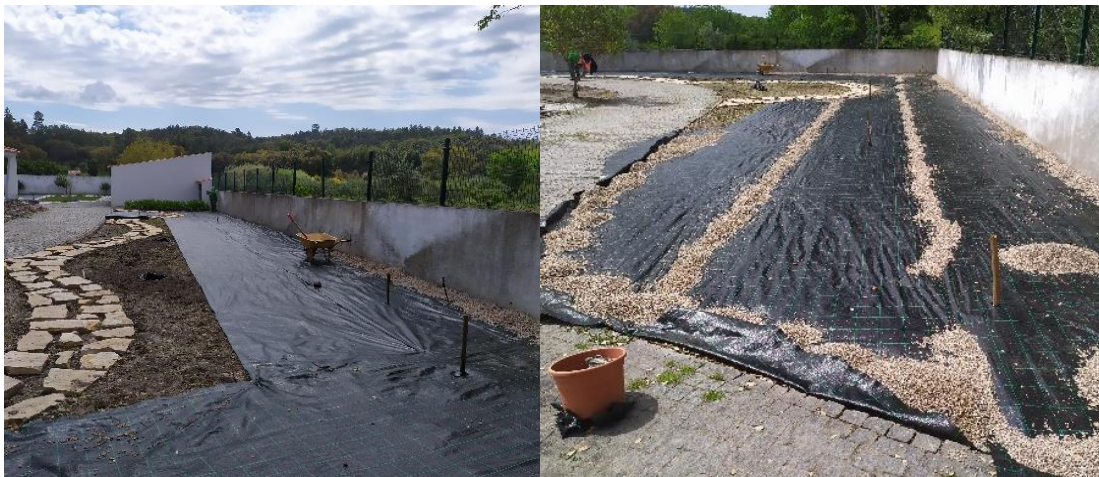
Figura 10: aplicação de manta anti-ervas e “burgau do rio”
