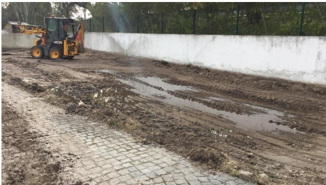
Figura 8: Decapagem com auxílio de retroescavadora
