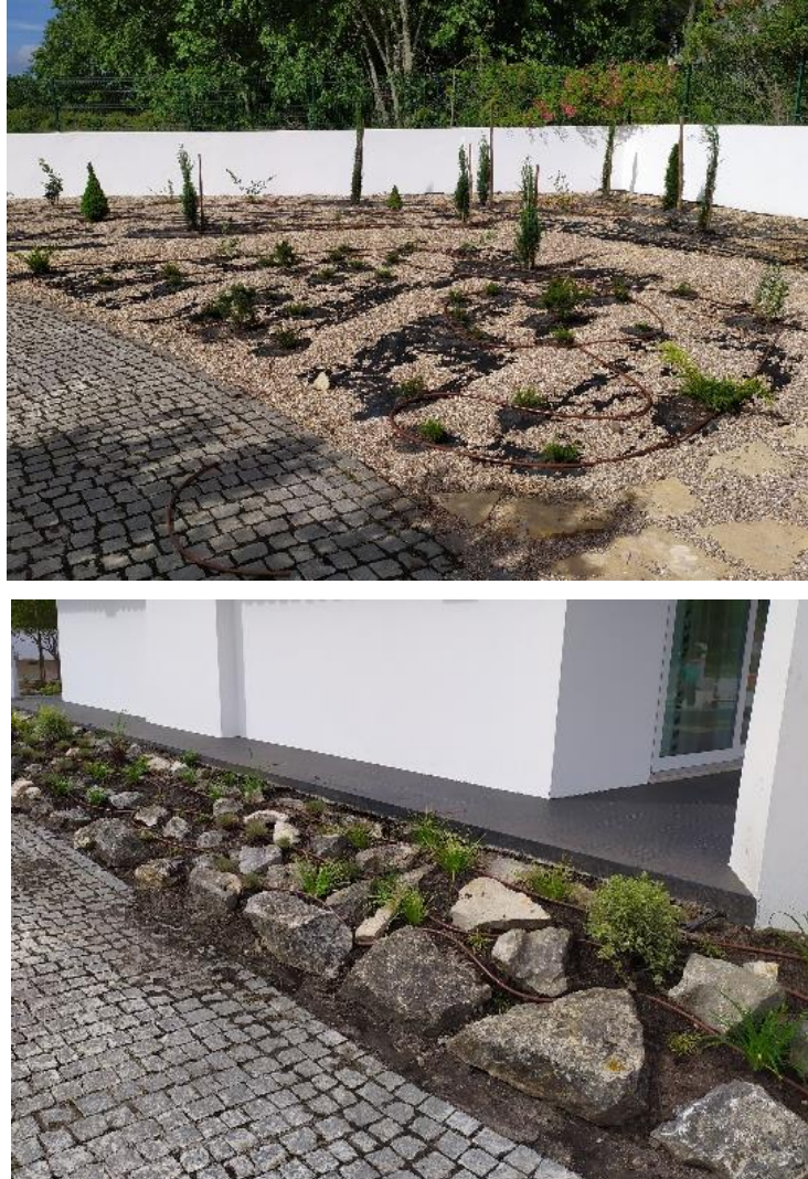
Figura 12: Instalação do sistema de rega gota-a-gota
