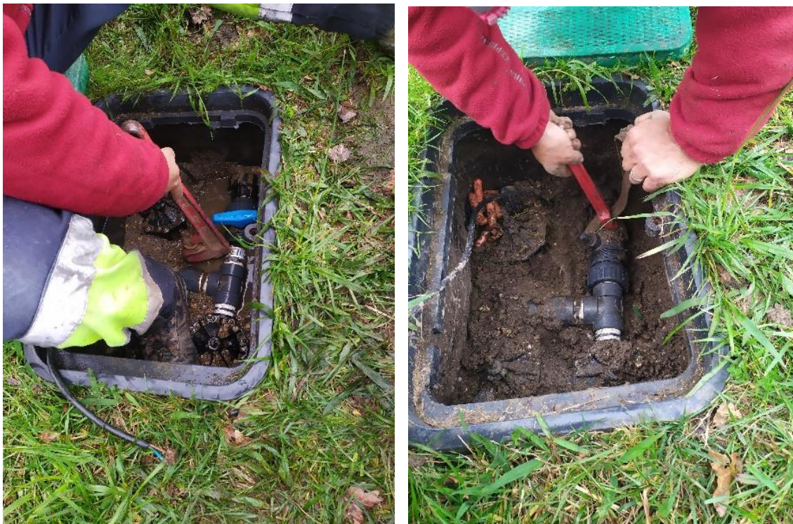
Figura 21 – Substituição de válvula de segurança
