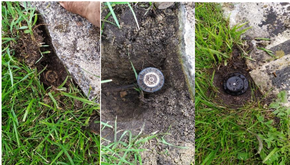
Figura 29 – Pulverizador soterrado, abertura de cova e conclusão da reparação
