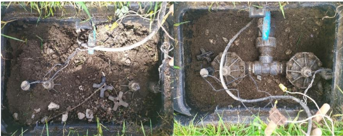
Figura 19 – Limpeza de caixas de rega
