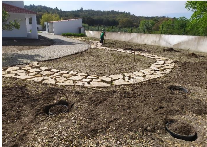
Figura 9: Lajetas irregulares de calcário e abertura de covas para plantação de espécies arbóreas
