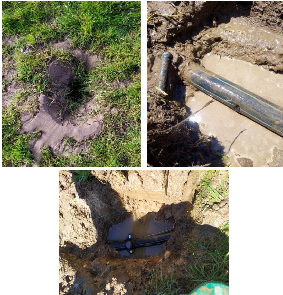
Figura 20. – Descoberta, exposição e reparação de tubagem de rega
