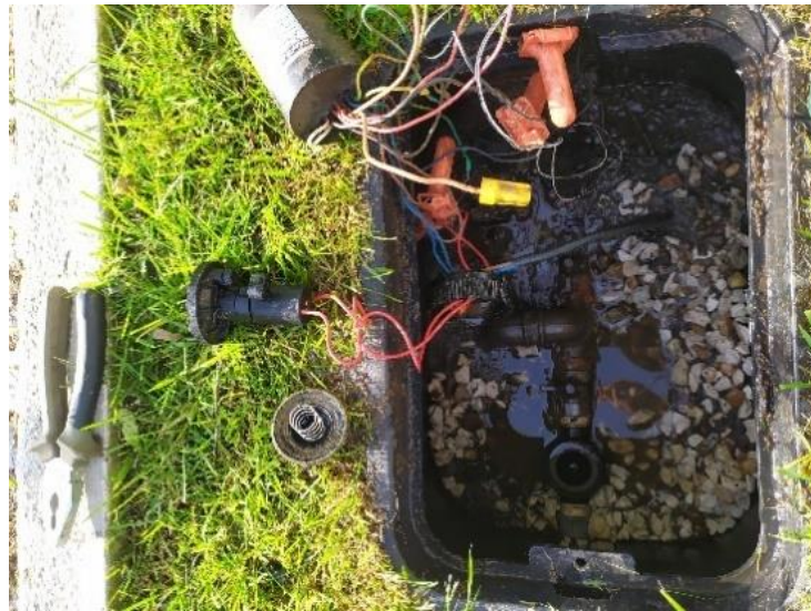
Figura 22 – Limpeza de borracha da válvula de solenoide
