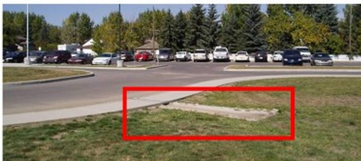
Foto 5 – Drenagem águas pluviais.
