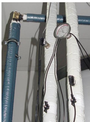
Figura 22 – Localização dos sensores para a medição do caudal e de temperatura junto ao depósito de acumulação.
