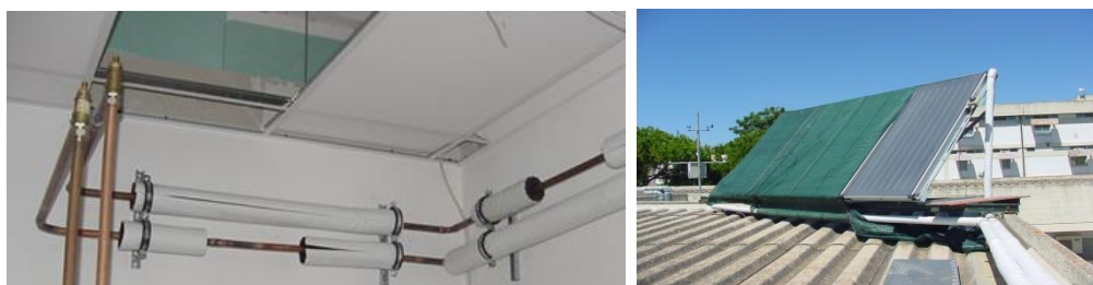
Figura 24 - Isolamento do circuito primário interior e exterior
