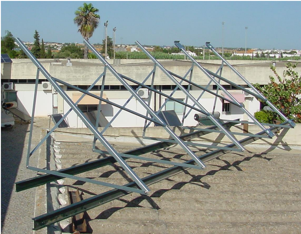
Figura 13 – Montagem dos perfis de suporte da estrutura
