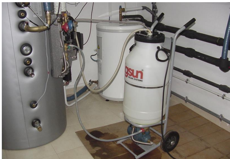
Figura 26 - Enchimento do circuito primário dos painéis solares térmicos com fluido térmico.
