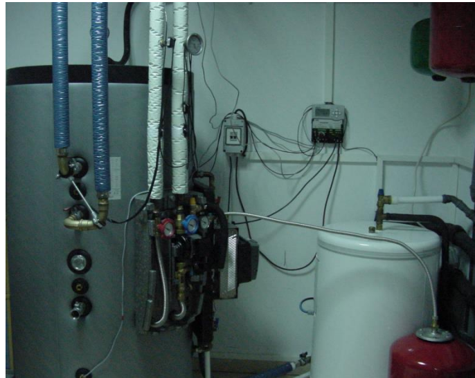
Figura 16 - Pormenor de ligação do circuito primário e secundário ao depósito de 400 litros.
