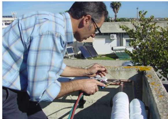
Figura 15 – Preparação e soldadura das linhas de cobre do primário
