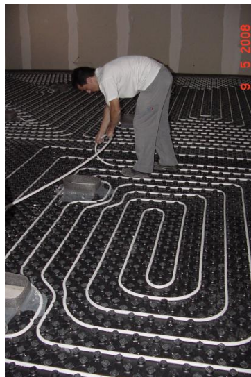
Figura 3- Pormenor da colocação do tubo para pavimento radiante.
