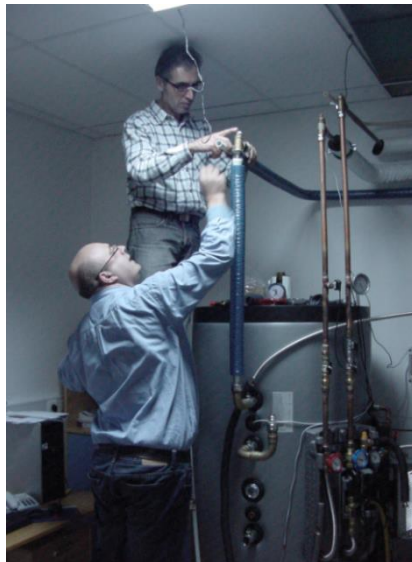
Figura 19 - Ligação dos purgadores do circuito secundário
