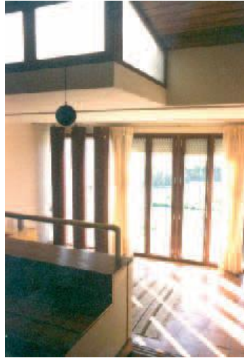
Figura 21 - Colunas de água na casa solar no Porto, Arqº. Carlos Araújo e Santiago Boissel) [66]
