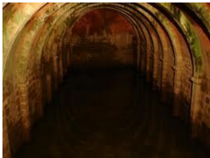
Figura 61 - Cisterna do Castelo de Marvão [29]
