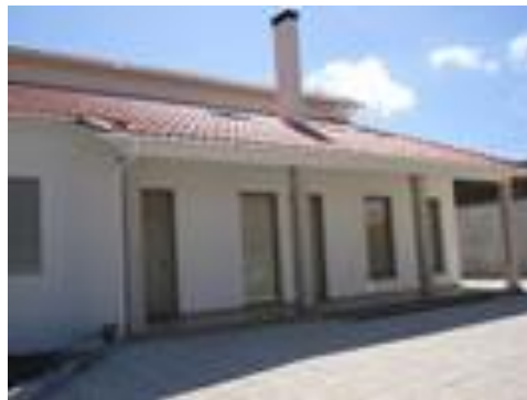
Figura 75 - Caleiras instaladas em moradia unifamiliar [24]
