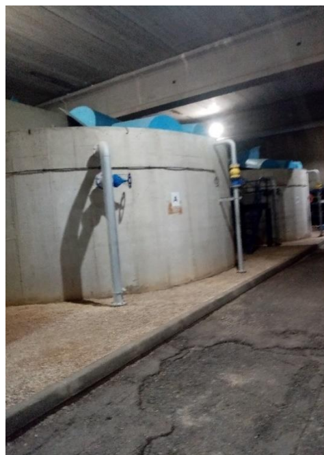
Figura 3.19 - Linhas de Espessamento Gravídico da ETAR de Vale Faro (Fonte: Autor, 2021)
