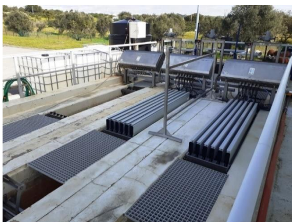
Figura 3.6 – Canais das UVs da ETAR de Albufeira Poente (Fonte: Autor, 2021)
