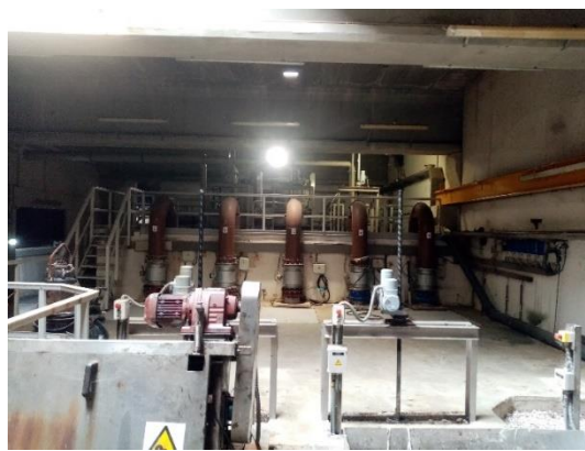
Figura 3.14 - Sistema de Gradagem da ETAR de Vale Faro (Fonte: Autor, 2021)
