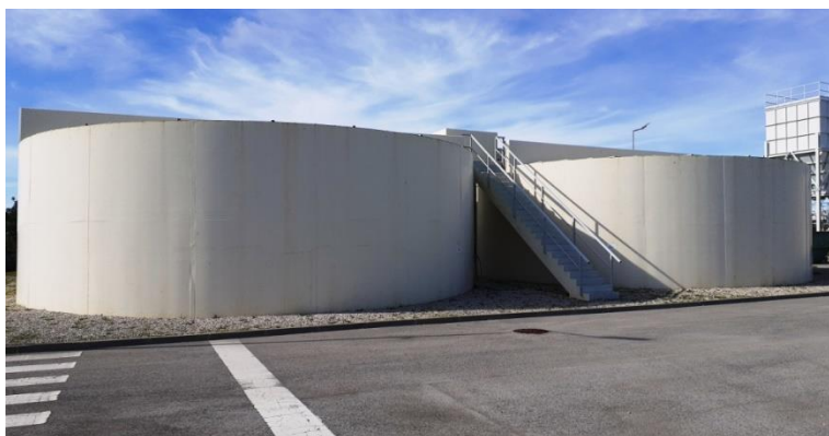
Figura 3.10 - Espessadores gravídicos de lamas da ETAR de Albufeira Poente (Fonte: Autor, 2021)
