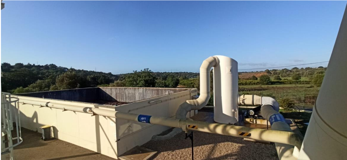
Figura 3.11: Tanque de desodorização biológica com biofiltro (Fonte: Autor, 2021)
