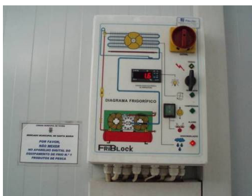
Fig. 2.10: Visor da câmara de frio n.º 1 (conservação produtos de pesca).
