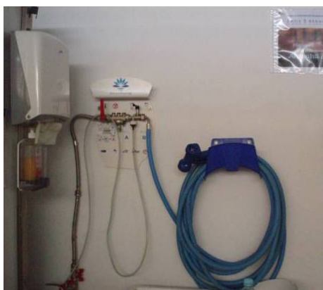
Fig. 2.20: Sistema de lavagem com doseamento automático da empresa Domotel.
