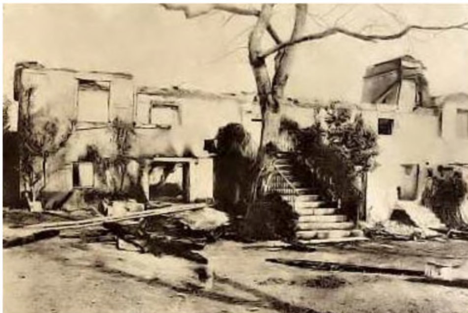
O estado de completa ruína em que ficou a casa de Camilo após o incêndio de 17-3-1925
