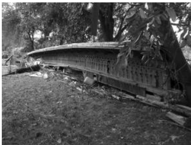
Figura 2.25 - Telhado de um pavilhão que flutuou para uma distância longa da sua origem devido à inundaç o (Drdacky, 2010).
