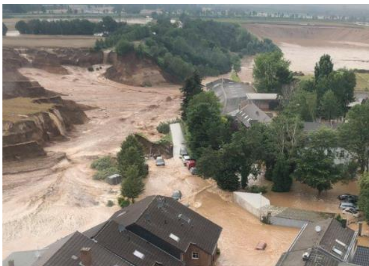
Figura 2.29 – Deslizamento de terra devido a uma inundação, Erfstadt-Blessem 2021 (BBC, 2021).
