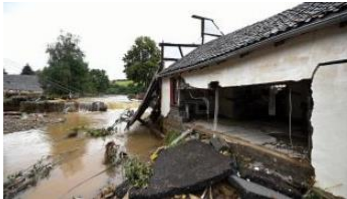
Figura 2.24 - Parede de uma residência destruída após inundação, Alemanha 2021 (Euronews, 2021).
