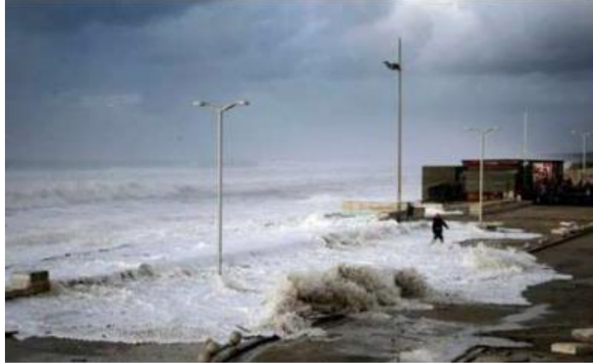
Figura 2.19 - Inundação costeira na praia do Furadouro, Ovar, Portugal (APA, 2020).
