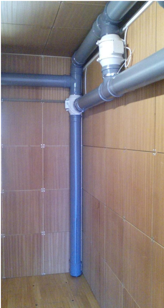
Figura 63: Circulação do cabo elétrico.
