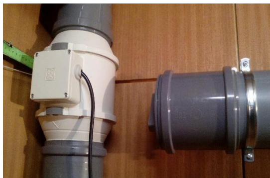
Figura 62: Montagem do ventilador na conduta de insuflação.
