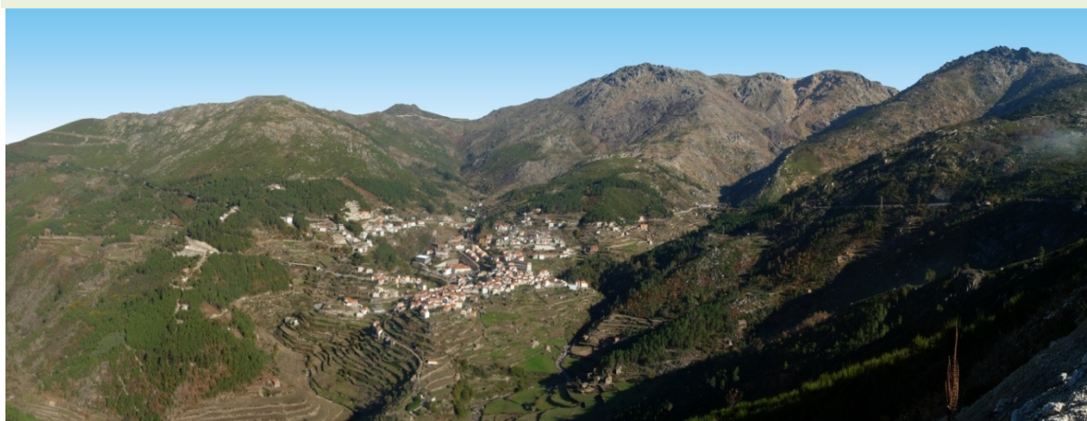
Figura III.33 - Panorâmica do Vale de Loriga - vista da Portela Selada Fonte: (Arquivo do PNSE, 2012).
