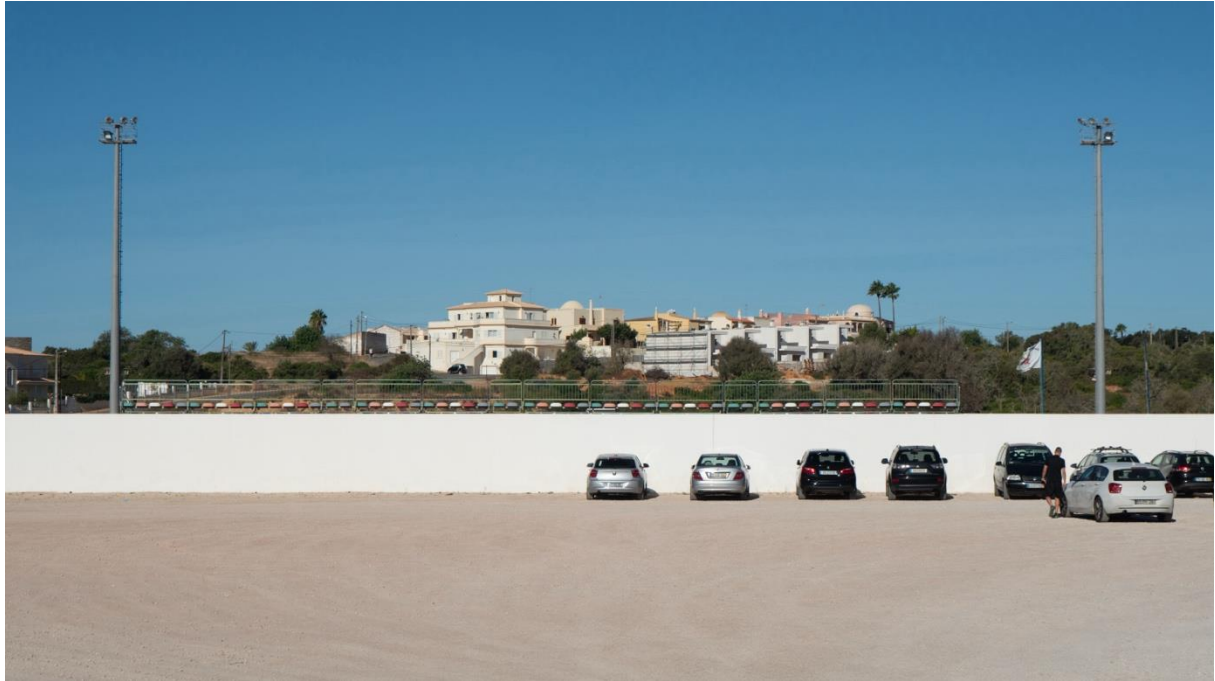
Figure 4.4 (a): Outside the Armação de Pêra Municipal Stadium.
