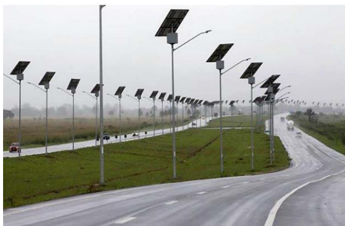
Figura 1.3: Instalação de postes solares fotovoltaicas em avenida de grande circulação [11].
