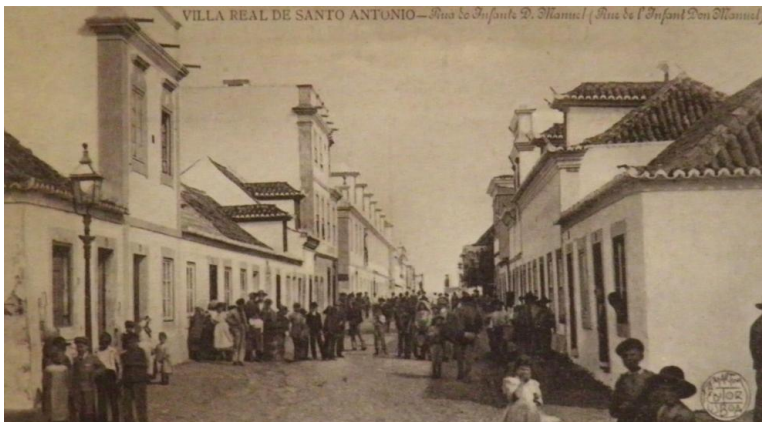
Figura 12 - Aspecto de uma das ruas de Vila Real de Santo António, na qual se destaca a grande variedade de soluções arquitetónicas utilizadas. Fonte: Fernando REIS, "O incêndio", in revista VRSA nº 2, 2010, pág. 71.
