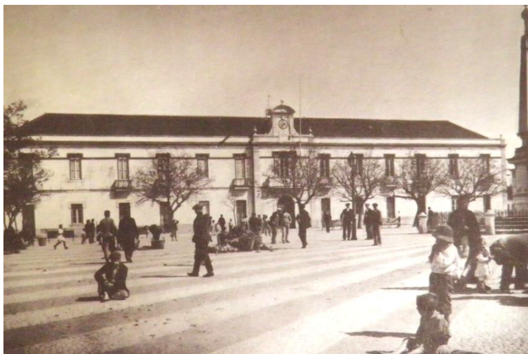
Figura 10 - Fachada principal do antigo edifício dos Paços do Concelho de Vila Real de Santo António, inaugurado em 1912 e demolido em 2006. Fonte: Fernando REIS, "O incêndio", in revista VRSA , nº2, 2010, pág. 69.
