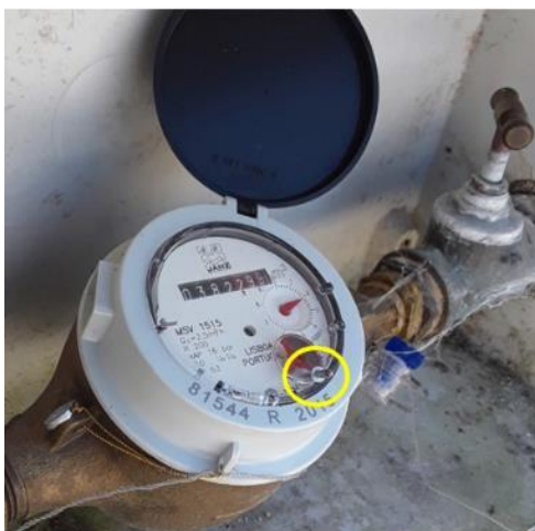
Figura 5. Utilização de um arame para evitar a contagem da água
