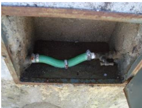
Figura 3. Furto de água através de ligação direta
