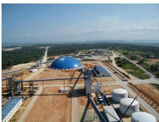
FIG 4.9 Fábrica de Cimento e sua envolvente a Sul
