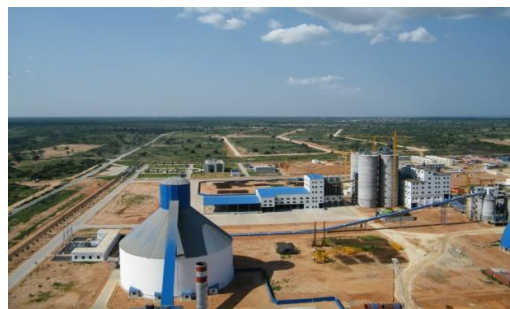
FIG 4.8 Fábrica de Cimento e sua envolvente a Norte
