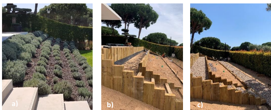
Figura 2.35. Fotografias da evolução da obra do Lote São Lourenço Norte 01, Quinta do Lago. Imagens obtidas por câmara fotográfica a) a 7 de abril 2021; b) a 8 de abril 2022 e c) 6 de maio, 2022. Fonte: Autora, 2022.
