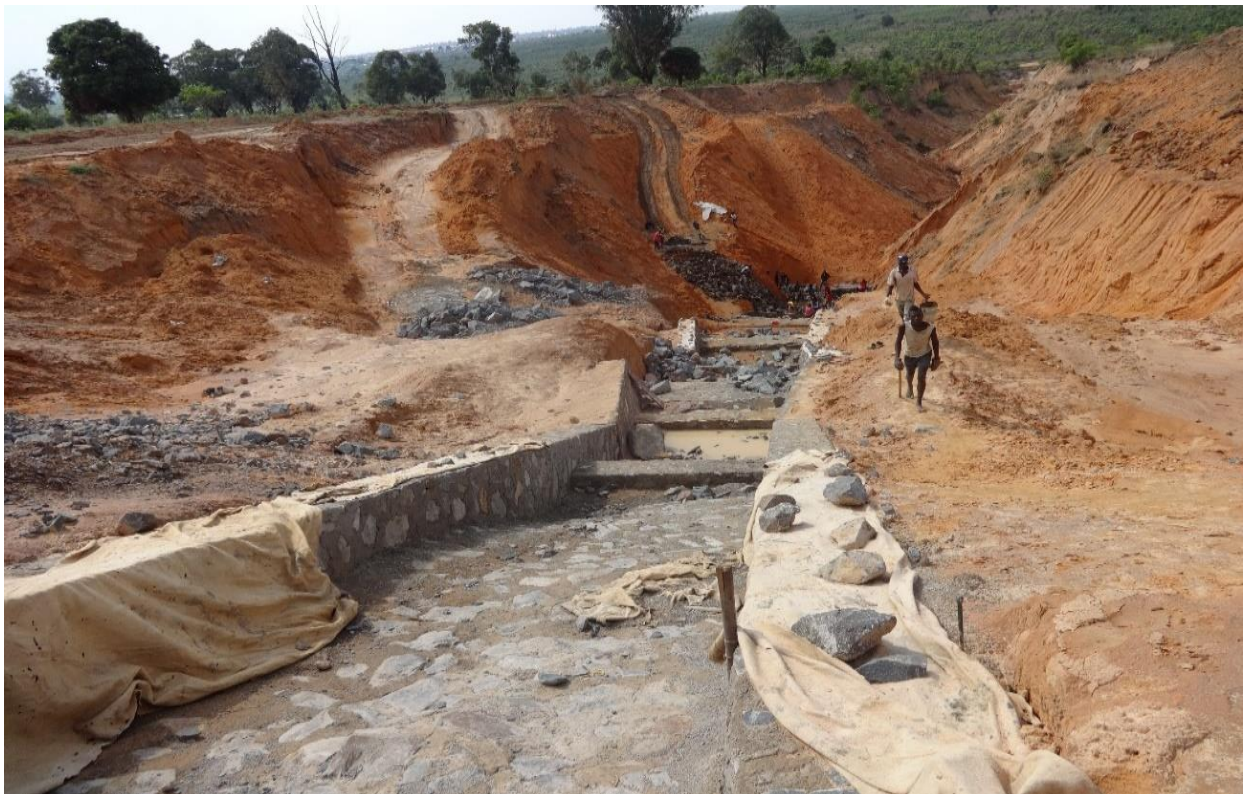
Figura 6 - Foto da ravina 2, trabalhos de contenção
