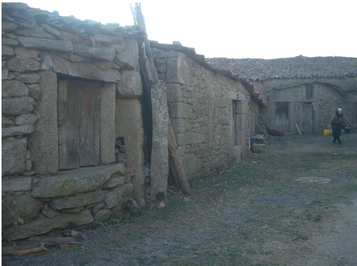
Fig. 5 Fonte da Aldeia, concelho de Bragança. Casas em alvenaria de granito com paredes interiores em adobe
