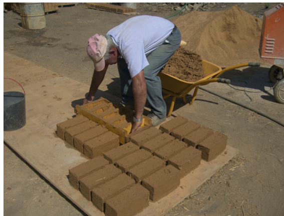
Fig. 4 A produção de adobe para a construção de paredes interiores na reabilitação de casa em Angueira, 2008
