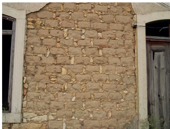
Fig. 6 Tomar, alvenaria de adobe com "escacilhos" em pedra
